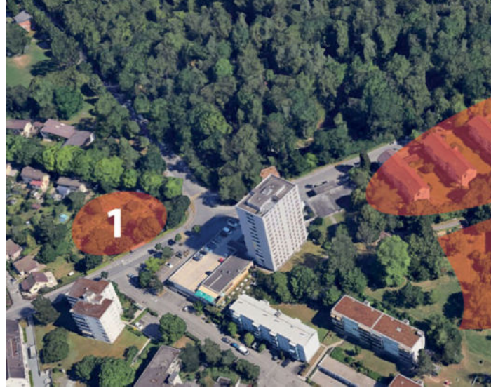
Blick von oben auf die geplanten Grossbaustellen (Quelle: Google)
